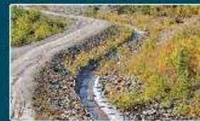
16. Vangorda Creek Diversion
